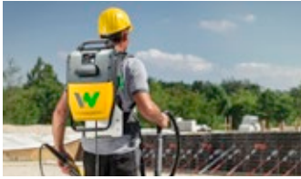
Technika na úpravu betonu
