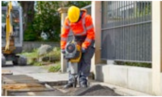
Tecnica di demolizione
